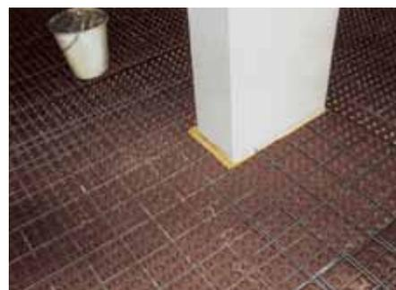
Установленные между фундаментной плитой и стяжкой пола листы DELTA®-MS 20 улавливают любую проникающую снизу воду, появляющуюся в результате подъема уровня грунтовых вод, и передают ее в дренажную трубу.
