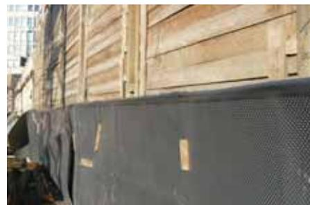
Благодаря самоклеящимся лентам, встроенным в зону нахлёста рулонов, цементное молочко во время бетонирования не попадает в фильтрующий/дренажный слой и не может его закупорить.
