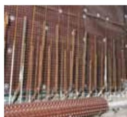
Пластовый дренаж подземных сооружений на вертикальных и горизонтальных поверхностях.
