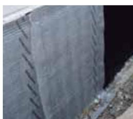
Дренажная мембрана с двусторонними выступами. Отличная вентиляция стен.
