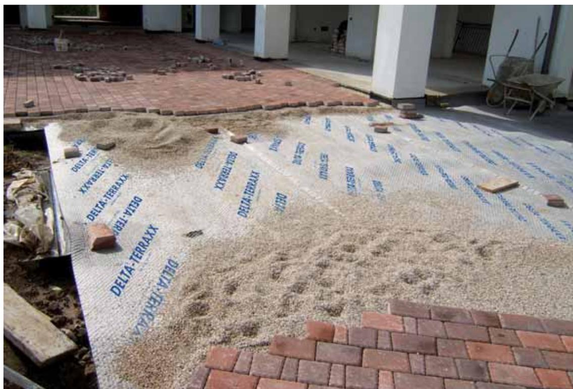
■ Гидроизоляция, стойкая к сжатию
